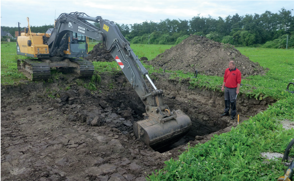
Aanleggen testputten.
